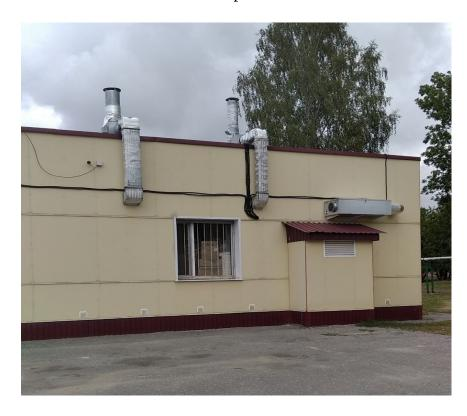
Продолжена работа по замене участков труб систем водо - и теплоснабжения в инфекционном корпусе. Продолжаются работы по подготовке помещения под размещение аппарата МРТ (сделан фундамент и каркас здания из металлических конструкций, стены выполнены из утеплённых сэндвич - панелей), установлен в помещении аппарат МРТ.
